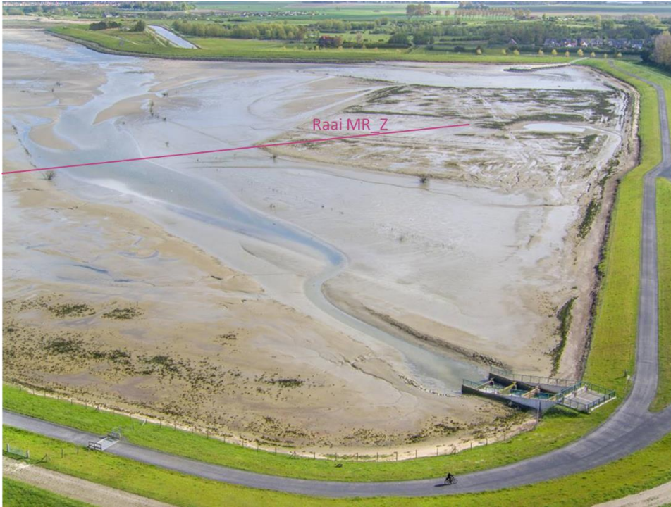
Figuur 2-9: Situering raai MR_Z in de nieuwe ontpoldering (aangepaste oblieke foto ANB).
