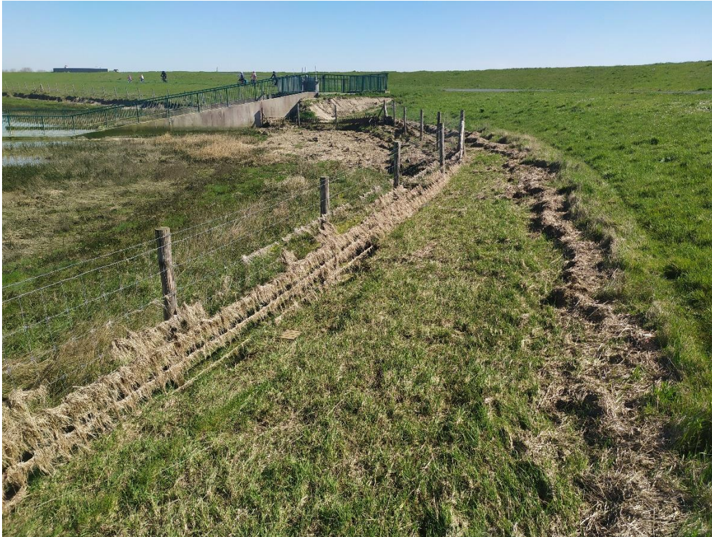
Fig.9.19. UZ7. Zicht op beide bodemvallen, aan de voet van de dijk, vlakbij het begrazingsraster. Het vele strooisel dat in het raster hangt, en de brede band van strooisel hoger op de dijk dan de bodemvallen, indiceren dat het water soms hoger komt dan waar de bodemvallen staan. Foto zuidoostwaarts genomen. 4 april 2023. Foto Jorg Lambrechts.
