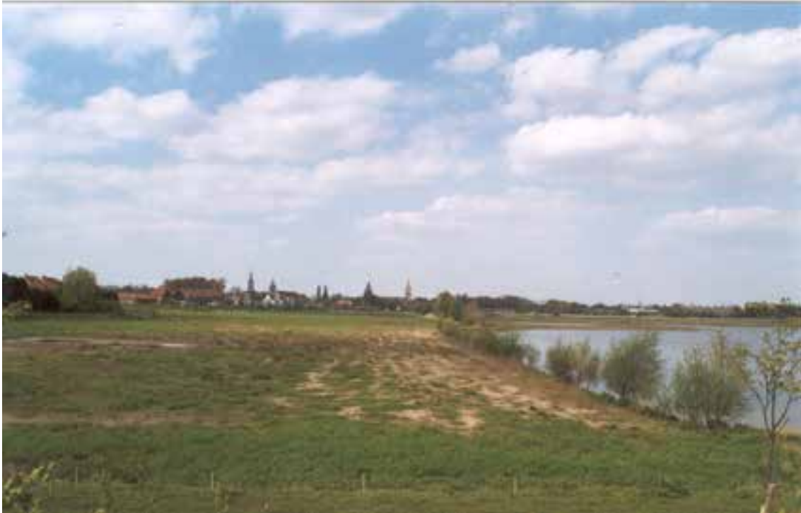
Fig 20: Zone 3 gezien vanop de zuidelijke dijk, kijkend richting Ieper net na het droogvallen. Ook hier markeert wilgenopslag de overgang van wacht- naar spaarbekken (foto dd. 17 IV '02).
