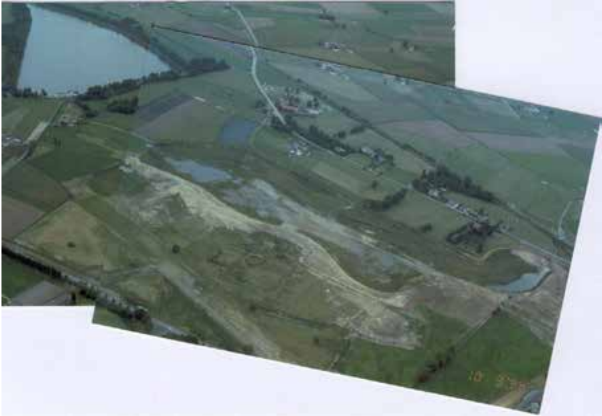
Fig 7: Aanlegwerken voor het spaarbekken/wachtbekken in volle gang. Bemerkt de ruimtelijke samenhang met de toevoerbekken, Zillebekevijver en de noodopgravingen tussen de bedding van de nog niet aangelegde N-37 en het spaarbekken gedeelte (foto dd. 10 IX '95, J. Semey).
